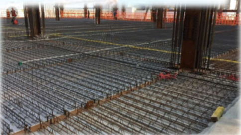
Thi công liên kết sàn Deck
