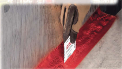
Thi công ngăn cháy lan
