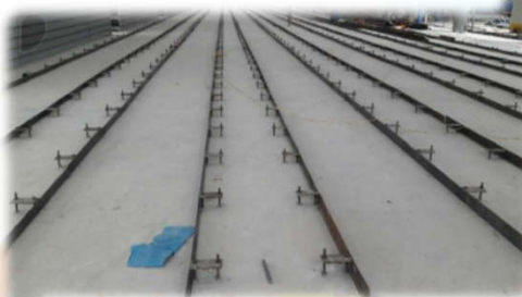
Thi công bulong Hóa chất hệ ray nhà máy cọc bê tông
